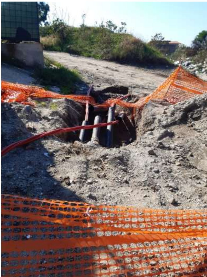
Foto 4 – Presenza di nuova linea telefonica interrata. 2° Intervento
