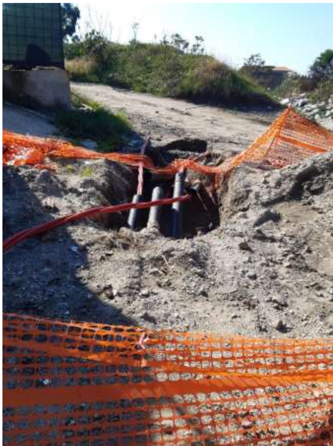
Foto 6 – Presenza di nuova linea telefonica interrata. 2° Intervento
