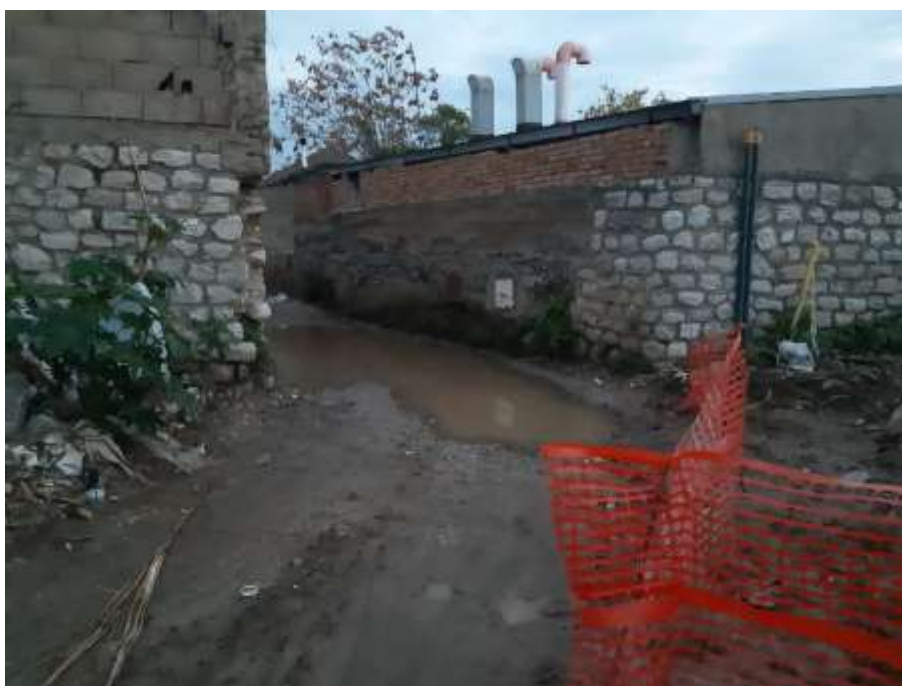
Foto 3 – Presenza di tubazione di sfiato rete gas in sinistra idraulica. 2° Intervento
